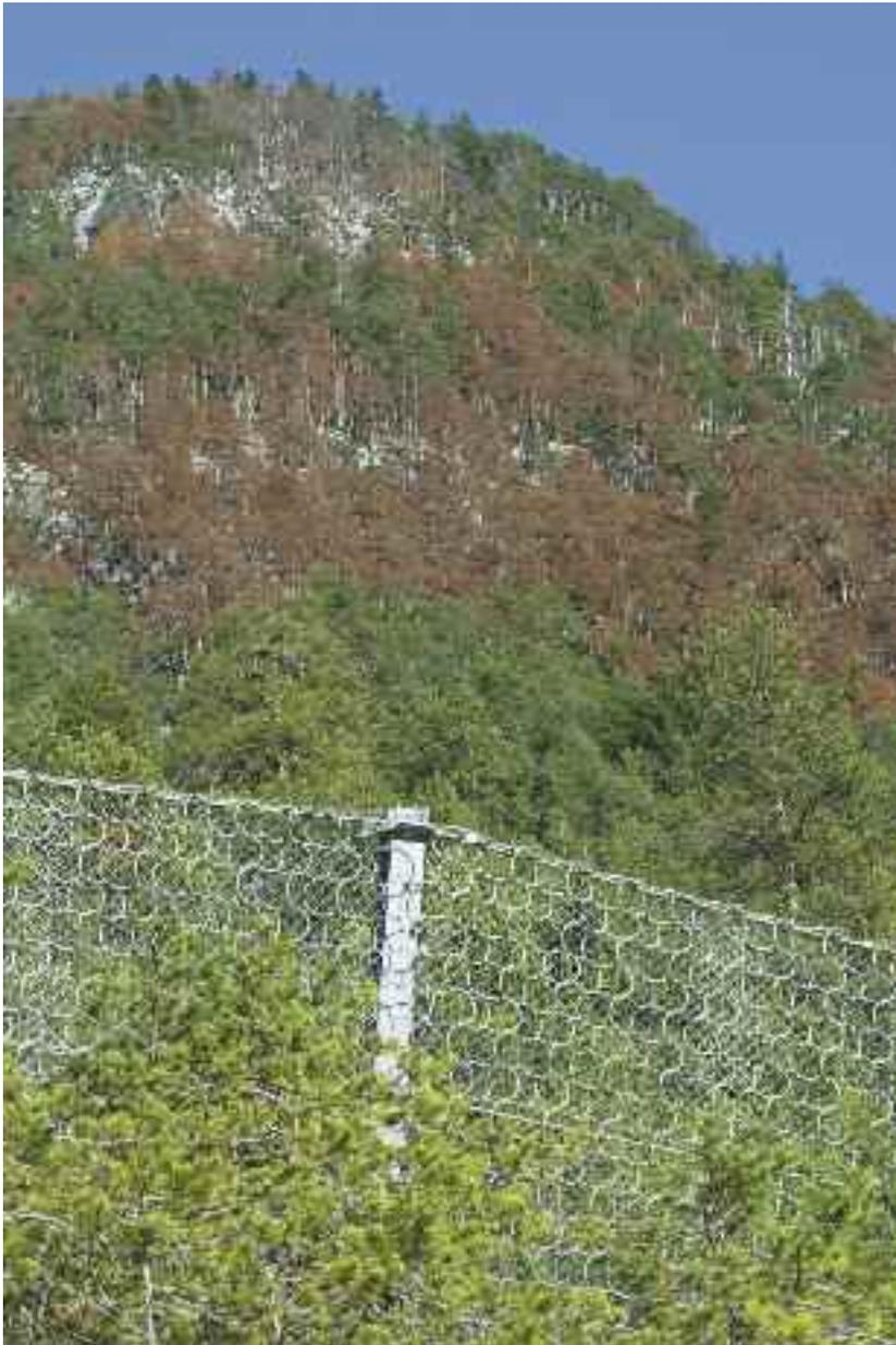
Abbildung 2: Der Sechszählige Kiefernborkekäfer (*Ips acuminatus*) brachte Kiefern auf einem steilen, felsigen Hang zum Absterben. Steinschlagnetze müssen die verlorene Schutzwirkung kompensieren.
