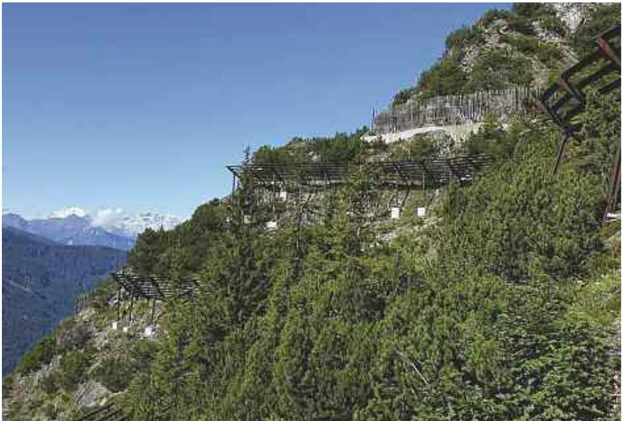
Abbildung 1: Technischer Lawinen- und Steinschlagschutz im Wald.
