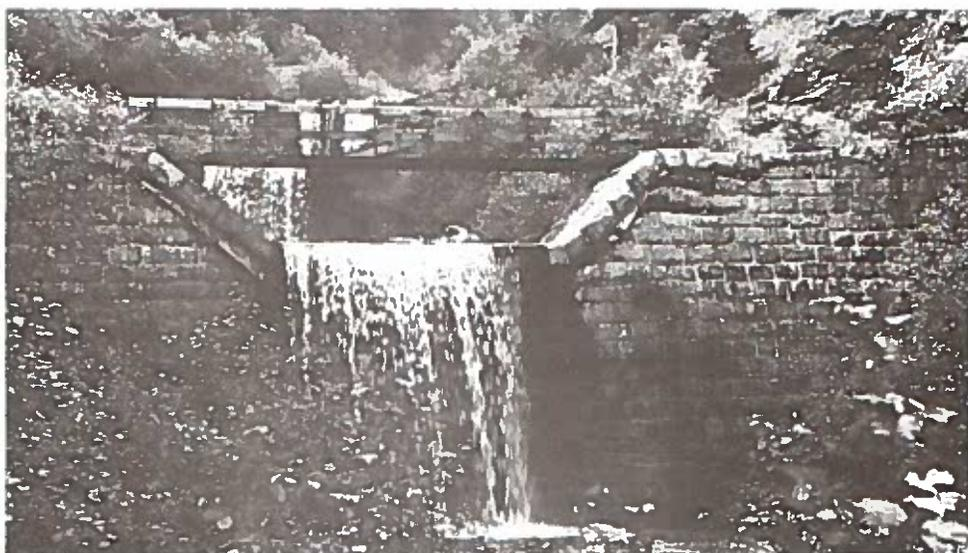
Abb. 29: Durch Gebirgsdruck beschädigte "Stegsperre" in hm 29,74
