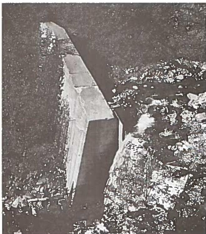
Abb. 30: Verschiebungen in der Gliedersperre in hm 30,50 (vergleiche Abb. 14).
