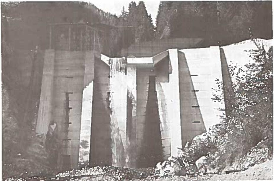
Abb. 8: Die sog. Pokornysperre in hm 21,5 nach Betonvorbau im Jahre 1975 mit der Winkelstütze der zweispurigen Materialseilbahn
