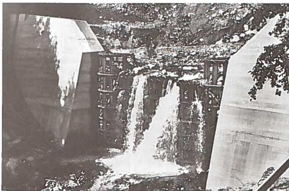
Abb. 35: Reihenkorbsperre in L-Form in hm 33,78 im September 1977
