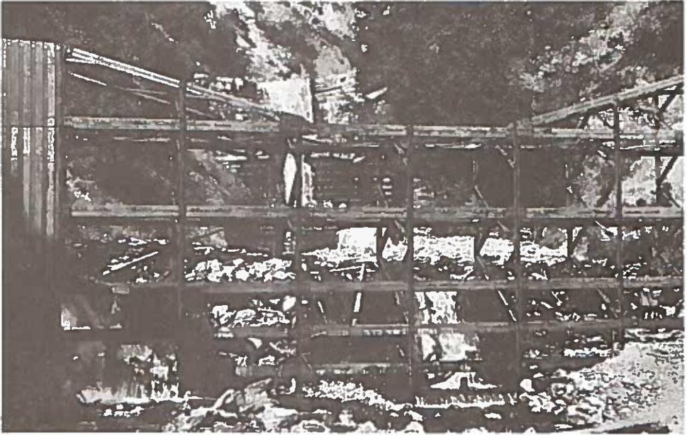
Abb. 31: Die halbverlandete Gitterrostsperre in hm 30,25 im September 1970
