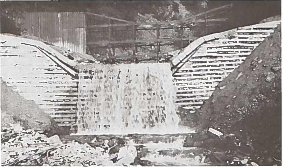
Abb. 1: Gebirgsdruck-Schäden an der Kastensperre mit Stahlbetonbalken
