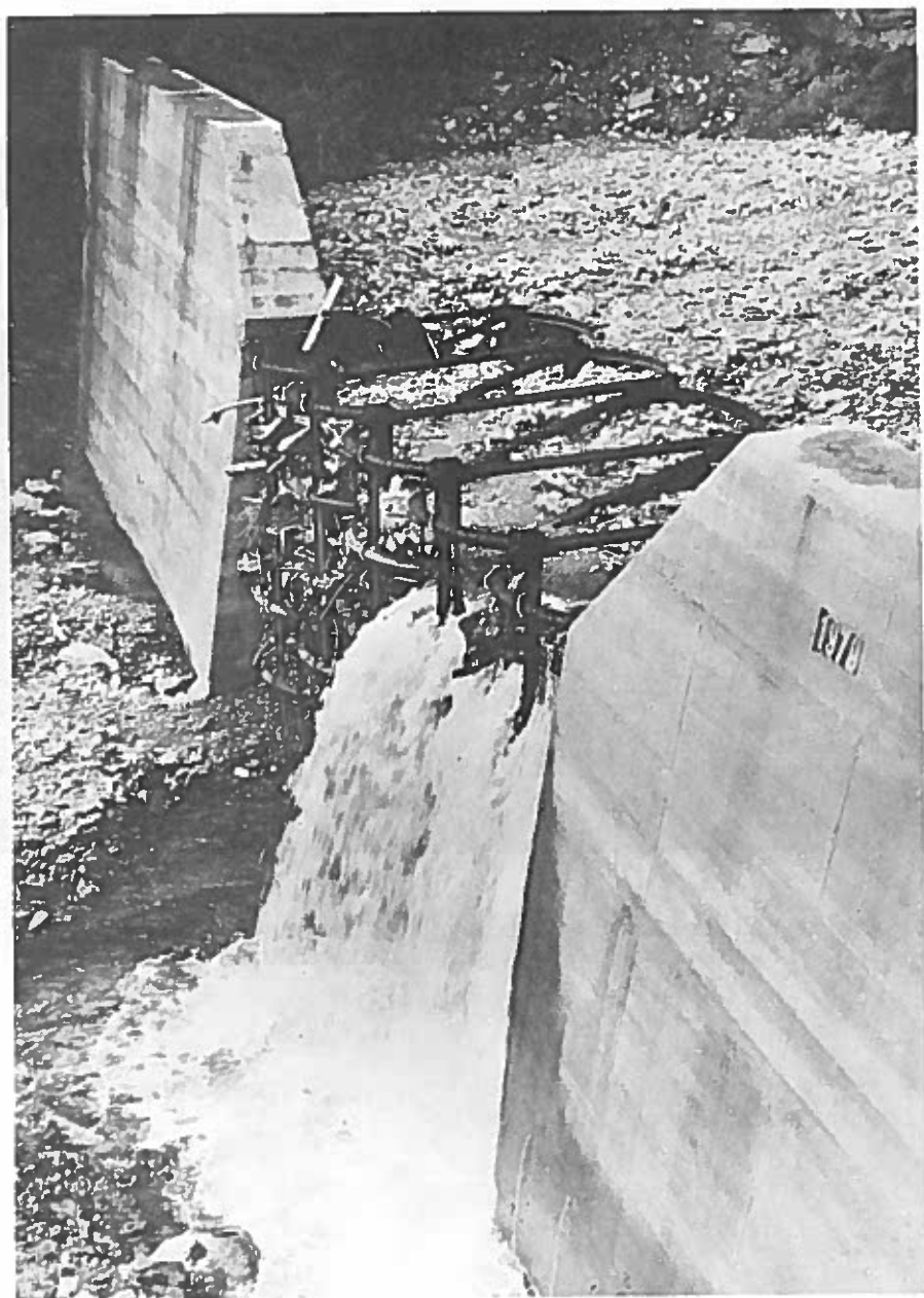
Abb. 3: Reihenkorbsperre im Dürnbach im Oberpinzgau, Salzburg im halbverlandeten Zustand
