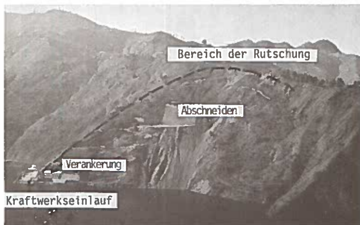
Abb. 9: Große Rutschung, die sich unmittelbar am Speicher des Kraftwerkes ereignet hat. (im "Kulekhani"-Einzugsgebiet) Das Rutschung hat etwa folgende Ausmaße: Breite: 170m, Länge: 350m, Volumen: 1.2 bis 1.5 Millionen m^3 Tiefe der Gleitfläche: 20-30m Am Rand des Rutschgebietes liegt der Kraftwerkseinlauf. Daher sind vollständige Gegenmaßnahmen unbedingt nötig. Nachdem zahlreiche Untersuchungen durchgeführt wurden, sind folgende Gegenmaßnahmen ergriffen worden. 1) Verankerung 2) Abschneiden 3) Entwässerung
