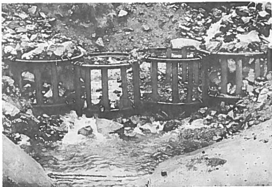
Abb. 2: Reihenkorbschwelle im Dürnbach, Oberpinzgau, Salzburg
