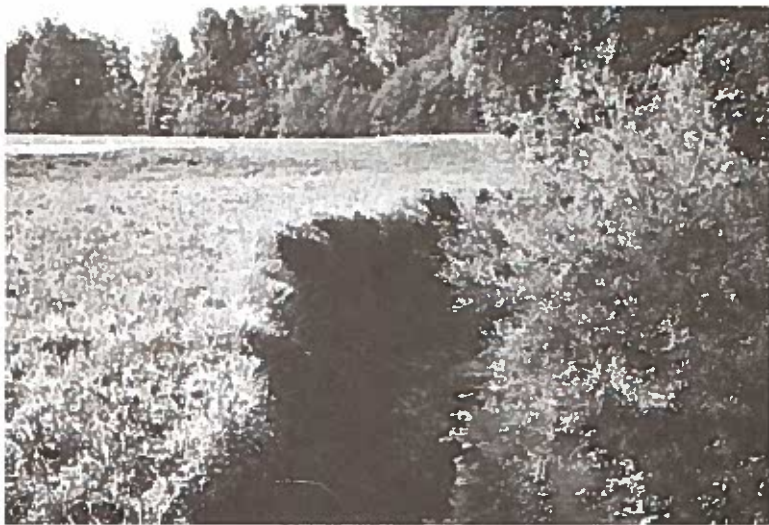
Abb. 3: Die Lebensgemeinschaften der Bachufer werden im Bereich von Uferanbrüchen völlig zerstört. Darüber hinaus wirken sich Uferanbrüche in Wildbächen mit Geschiebeüberschuß weit ins Unterwasser negativ aus.
