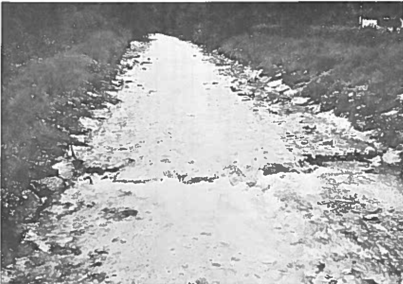
Foto 37: Diese naturnahe Verbauung hat zu wenig Breitenheterogenität und eine falsch gekrümmte Schwelle.
