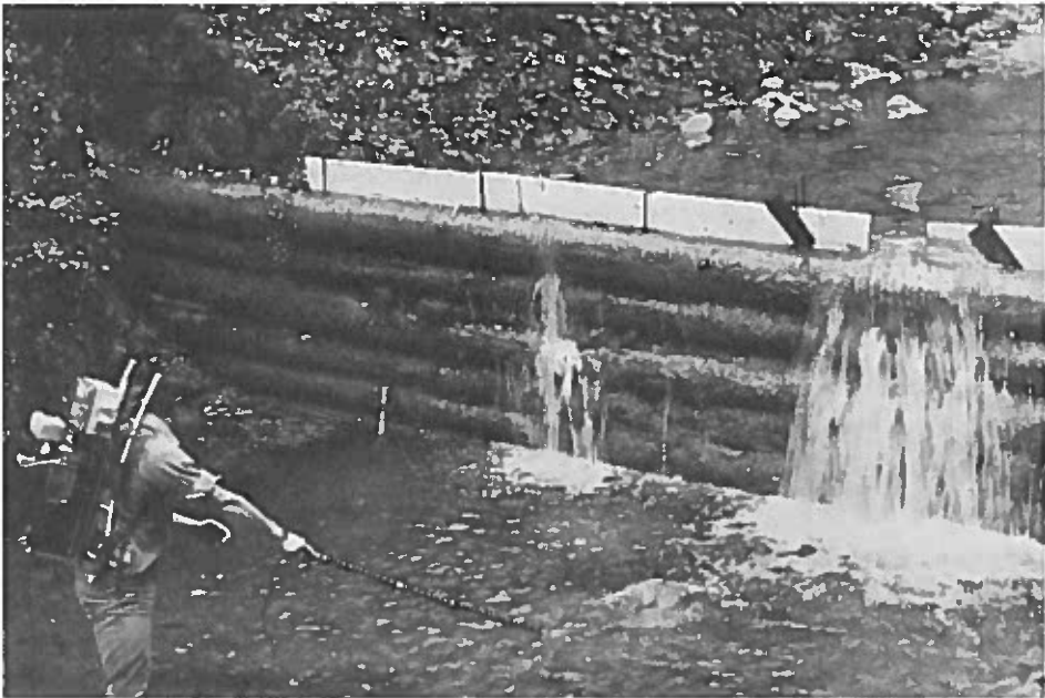
Foto 21: Sperre 8 (hm 12,45) mit verengter Abflußbreite für den Fischeufstieg (Kap. 9.3.6) und E-Befischung des Kolkes (Kap. 9.3.5).
