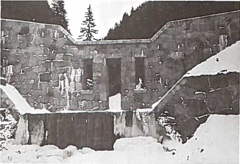
Foto 28: Die zu hohe Vorsperre unterbindet den Fischzug bereits vor Erreichen der "fischfreundlichen" Rückhaltesperre.
