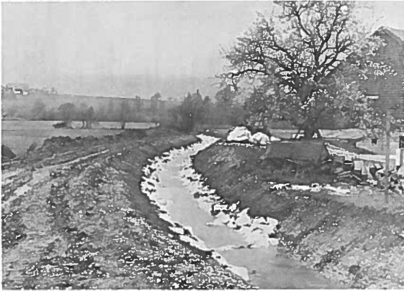
Foto 36: Die Unterlaufverbauung mit Wurfsteinen zur Ufersicherung und mit in die Sohle verlegten Einzelsteinen erzeugt ein hydrobiologisch günstiges Biotop.
