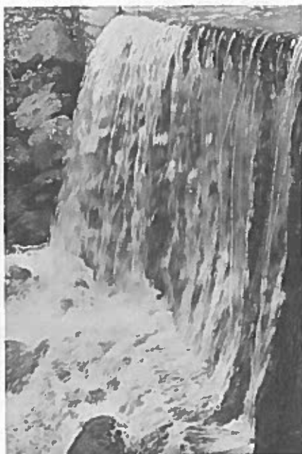
Foto 26: Das vorspringende Fundament verursacht beim Abdriften der Fische schwere bis tödliche Verletzungen.
