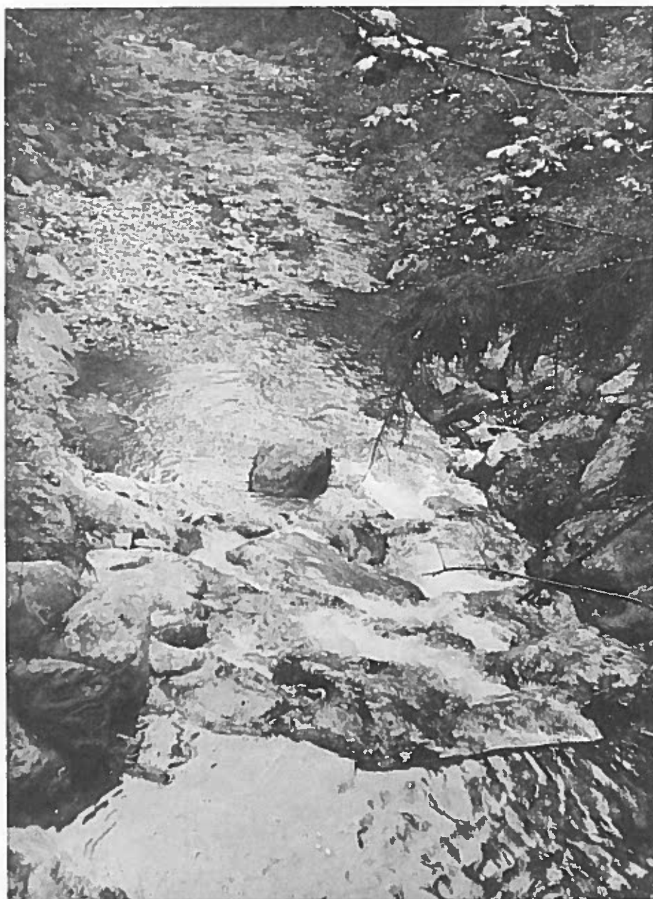
Foto 33: Die Sohlrampe im Dixelbach fördert die Breiten- und Tiefenheterogenität und bietet beste Fischeinstände.
