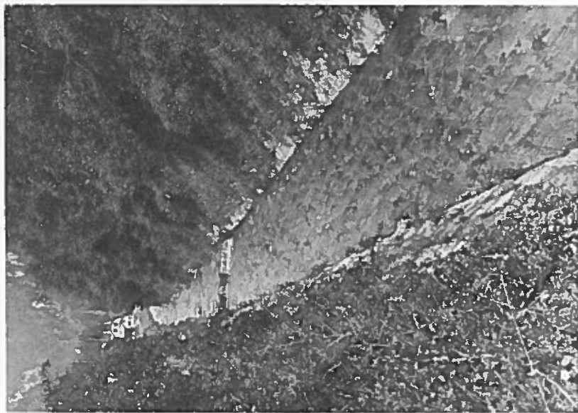
Foto 30: Diese Schale ist zu lange, hat eine zu breite Sohle und daher eine zu geringe Wassertiefe für den Fischzug bei Niederwasser (Abb. 53a).
