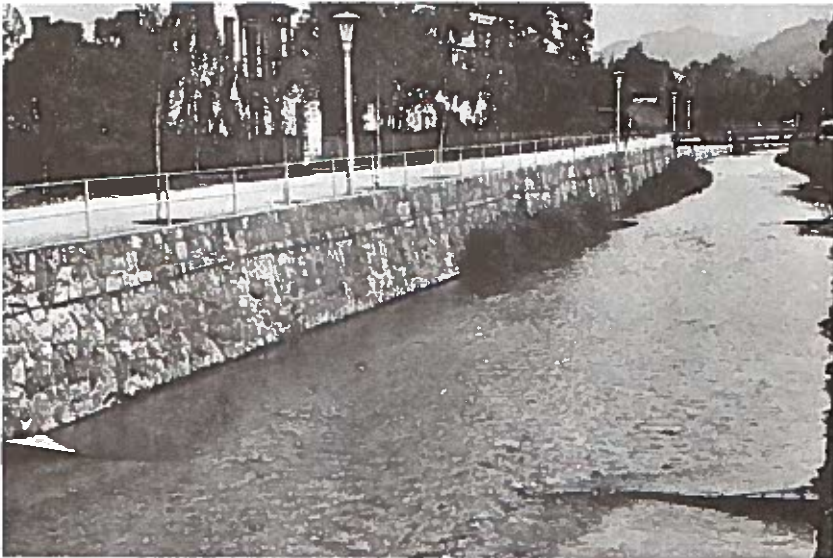
Foto 29: Dieses sehr gute Fischgewässer wurde ohne Rücksichtnahme auf Breiten- und Tiefenheterogenität "kanalisiert". Die auf Wunsch der Sportfischer eingebauten Buhnen bringen bereits eine Verbesserung.
