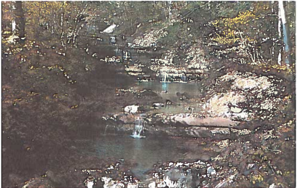
Foto 7: Abstaffelung von Grundschwelle 3 (hm 11,82) bis Grundschwelle 11 (hm 12,75) am Schwemmkegelhals in doppelw. Steinkastenbauweise und l. ufr. Leitwerk.
