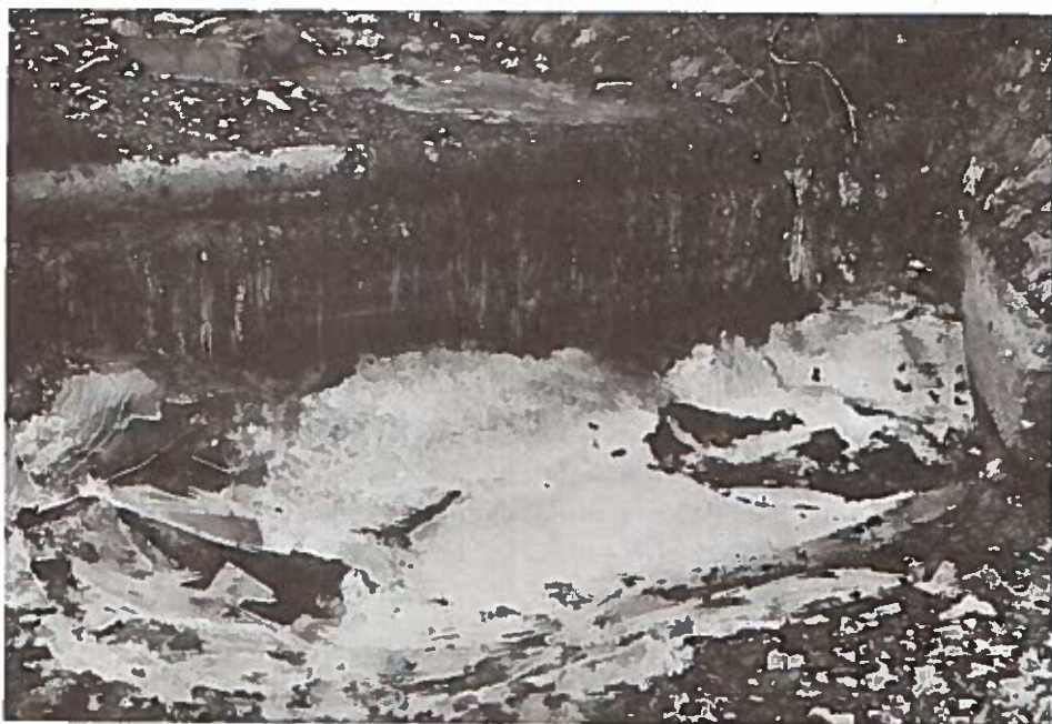
Foto 10: Sperre 6 (hm 12,14) am 15.11.1983; tiefe Nachttemperaturen ( -10^{\circ}\text{C} ) bei extremer Niedrigwasserführung ohne Überfall führen zur fast völligen Aufeisung und Fischverlusten. Sp. 2 bis 5 eisten völlig auf.
