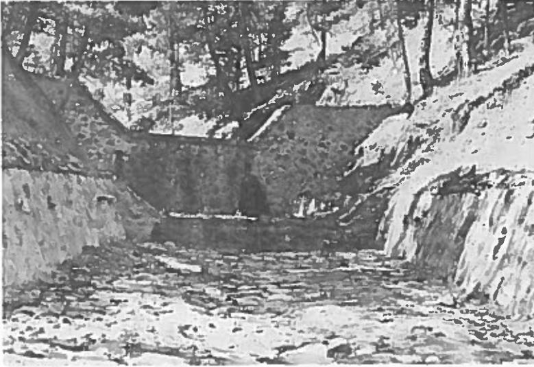
Abb. 3: Talsperre mit Sturzbettsicherung im Soğuksu-Tal (Kizilcahamam bei Ankara).
