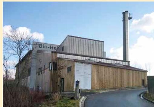
Biomasse-Heizkraftwerk Wolnzach Foto: M. Pflügler
