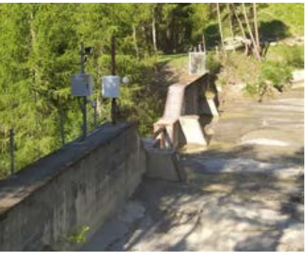
Abbildung 3: HF-Radar auf Retentionsbauwerk.
