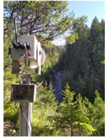
Abbildung 7: HF-Radar mit »Blick« auf den Dawinbach.
