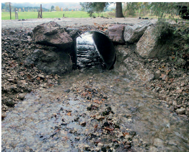
Spezialrohr als Wanderhilfe für den Steinkrebs (Bild: H. Haseke).
