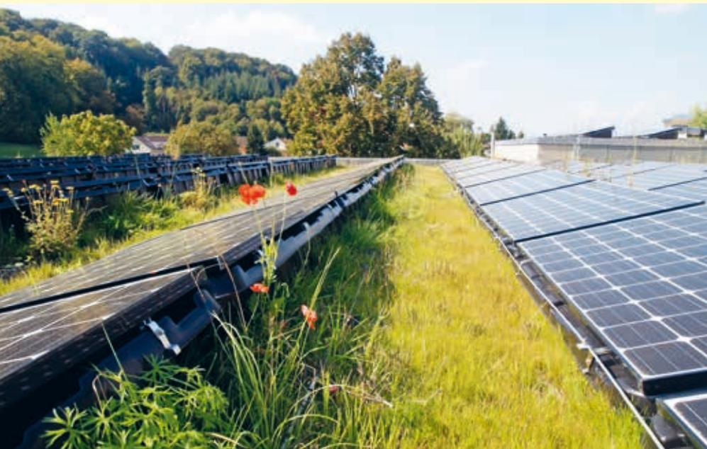
Fotovoltaik und Dachbegrünung – diese beiden Dinge funktionieren prima zusammen, wie hier auf dem Dach des Hallenbades Muttentz (BL).
