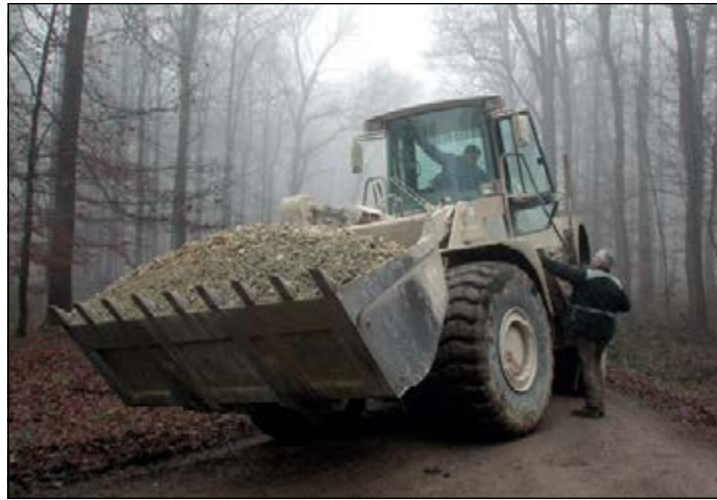
Ausbesserung von Problemstellen am besten mit Schotter.
