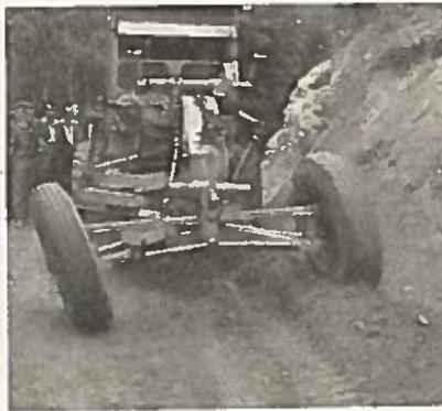
Abb. 11. Motorgrader Caterpillar Nr. 12 beim seitlichen Wegräumen des bei der Abböschung auf das Wegplanum gefallenen Erdmaterials. Wegbau Fusch-Roßkogel, Müritzal
