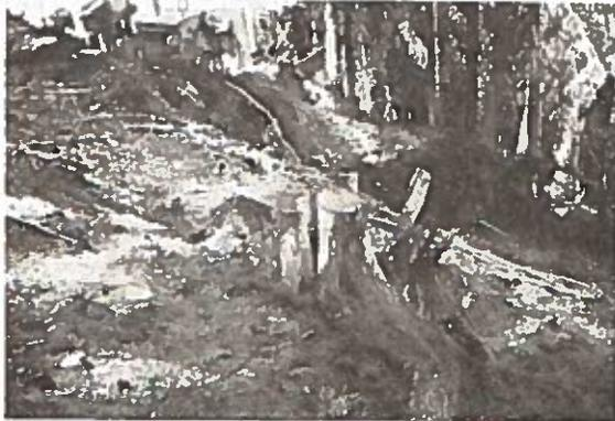
Abb. 20. Vorgesprengte Wurzelstöcke auf zu bauender Hangwegtrasse. Forstweg Mugel bei Niklasdorf
