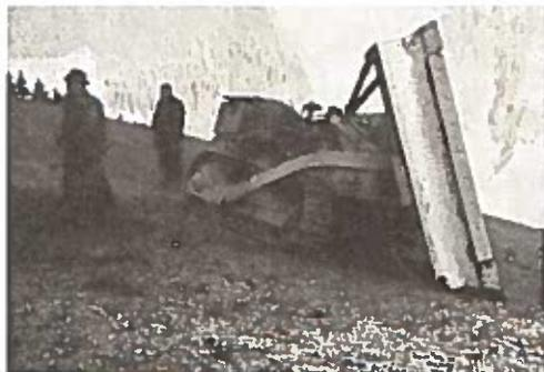
Abb. 16. Seitlich auf einer gefrorenen Wiesenfläche abgerutschte Planierraupe Caterpillar D 6 mit glattem Steg der Raupenplatten
