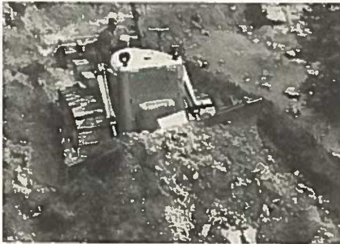
Abb. 4. Angledozer Caterpillar D 7 mit hydraulischer Bewegung der Planierschar
