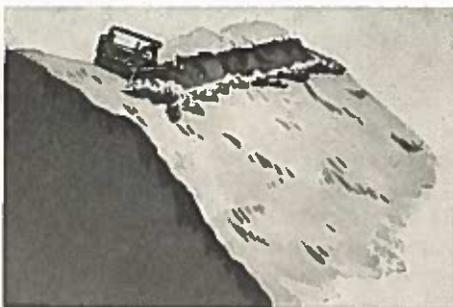
Abb. 14. Schichtweises Abschälen ganzer Erdlagen und Verschieben derselben zu den Orten ihrer Deponierung (Lagenbau)
