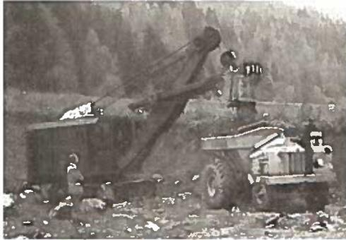
Abb. 15. Herstellung eines Querprofils nach der ganzen Fläche im Kopfbau durch einen Löffelbagger bei Beladung des gewonnenen Materials auf einen selbstfahrbaren luftgummi-bereiften Kipper
