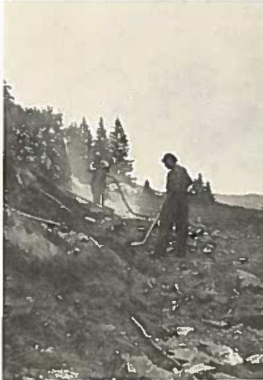
Abb. 21. Vorsprengung von gewachsenem Fels auf durch Planierraupen zu bauender Forstwegtrasse
