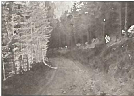
Abb. 32. Mittels Planierraupe fertiggestellter Rohbau eines Forstweges vor Herstellung der Böschung. Das Holz, das beim Trassenfreihieb anfiel, ist oberhalb der Trasse gelagert und kann auf dem fertigen Weg abgeführt werden
