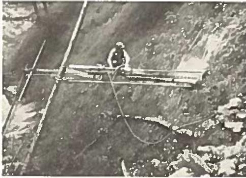
Abb. 33. Vorsprengung für Arbeit durch Planierraupen in reinem Felsgelände bei Forstwegebauten bei Reichraming O.Ö. Es werden horizontale Bohrlöcher in der Höhe der zukünftigen Wegsohle und gleichzeitig senkrechte Bohrlöcher an der bergseitigen Böschung des herzustellenden Anschnittes angelegt.
