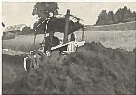
Abb. 25. Caterpillar D 4 Angledozer bei Wegebau St. Veit i. d. Gegend. Anschnitt der Rohtrasse (siehe Versuche 15 und 18)
