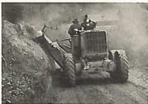
Abb. 29. Motorgrader Caterpillar Nr. 12 bei Herstellung der Böschung eines Forstweges
