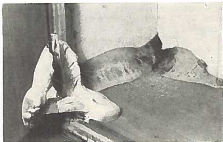
Abb. 9. Myzelpolster vom Hausschwamm ( Merulius lacrymans ) im Inneren eines eingehauten Schrankes
