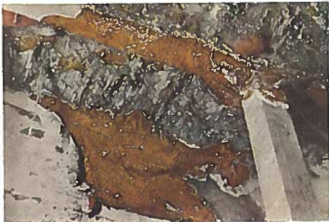
Fig. 1. Fruchtkörper des Hausschwammes ( Merulius lacrymans ), welche bereits die Pölung überwachsen haben
