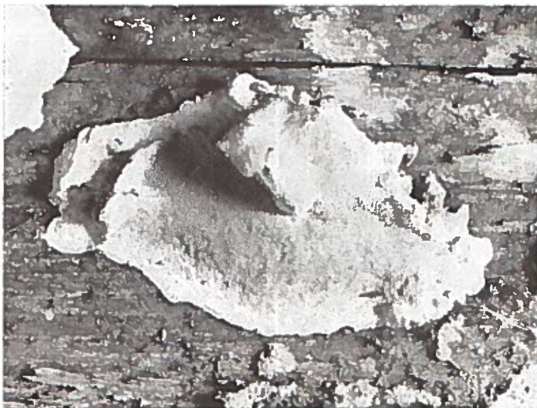
Abb. 21. Fruchtkörper der reihigen Tramete ( Trametes serialis ) auf der Unterseite eines Balkens
