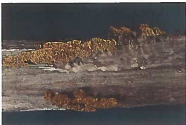
Fig. 1. Tannenblättling ( Lenzites abietina ) auf der Unterseite eines eingebauten Brettes hervorgewachsen
