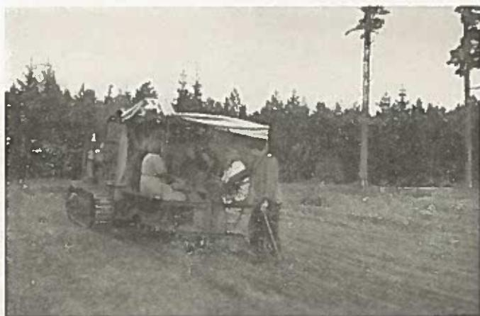
*Abb. 3b Robot-Pflanzmaschine Universal, überdacht, aufgesattelt auf 42 PS Famo-Raupe, beim Pflanzen. (Forstamt Rotenburg/Hann. Aufnahme Frühjahr 1951.)*
