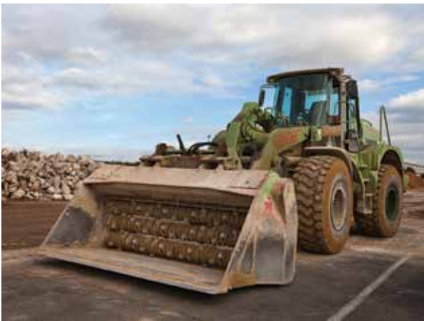
Abb. 4: On-Site Aufbereitung mittels Scheibenseparator.
