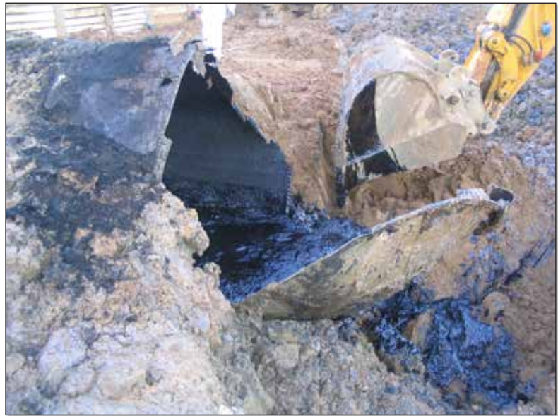
Abb. 6: Abbruch der Teergruben/Teerölkonditionierung.
