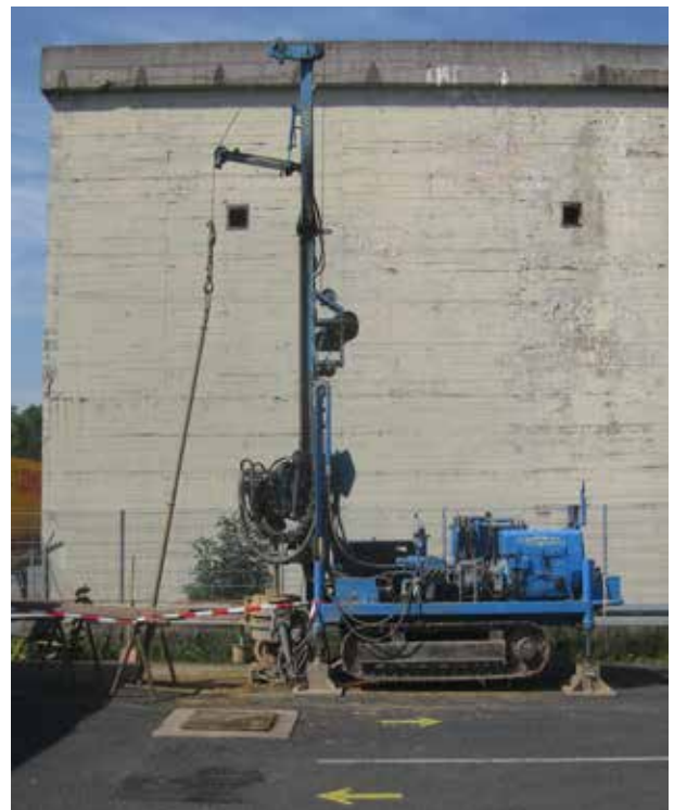
Abb. 2: Kernbohrung bei Erkundung.
