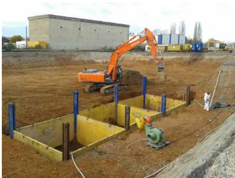
Abb. 8: Nassaushub im Gleitschienenverbau.
