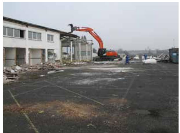
Abb. 6: Rückbau der Werkstatthalle.
