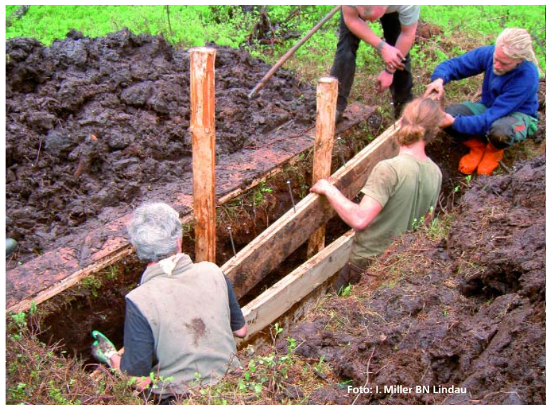
Abbildung 3: Mit dem Einbau schwerer Dielen wird der Entwässerungsgraben geschlossen und das Wasser im Moor zurückgehalten.
