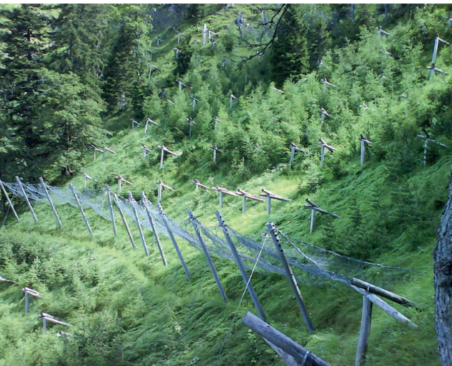
Die Schutzwaldsanierung kommt vielfach nicht ohne teure technische Maßnahmen aus.
