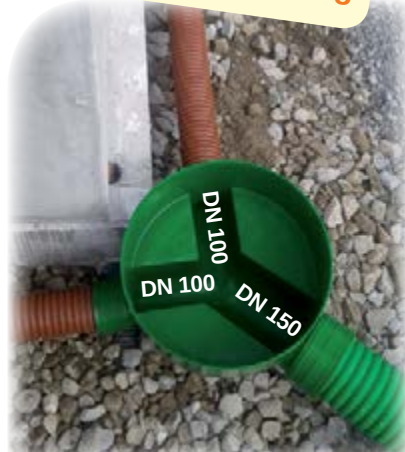
Teleskopadapter wird dem Einbau- niveau angepasst
