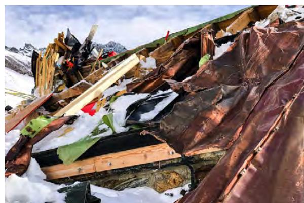
Abbildung 110: Das Dach wurde quasi «abgerollt» (Foto: N. und A. Naue).
