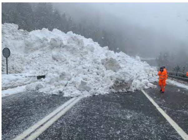
*Abbildung 117:* Lawinenablagerung des dritten Ereignisses (1. Februar 2021) auf der Rufigraben-Brücke A9 direkt nach dem Ereignis (Foto: ASTRA).
