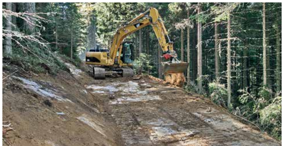
Forststraße in Baggerbauweise.
