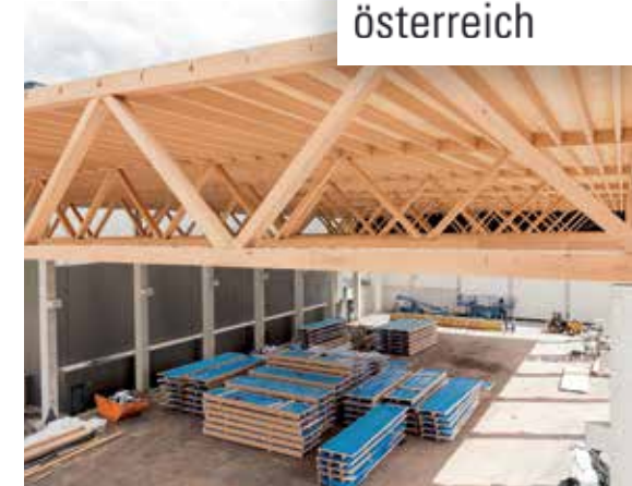
Lagerhallenüberdachung aus Buchen-Furnierschichtholz der Firma Pollmeier. Foto: Alex Schmitt
