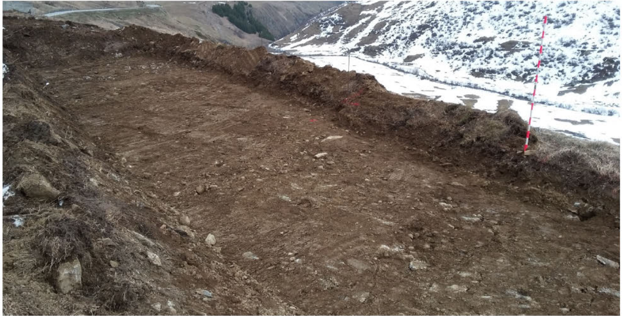
Abbildung 13: Auf 40 cm Mächtigkeit reduzierte Eindeckung im geplanten Testbereich mit Schutzwall zum Tal.
