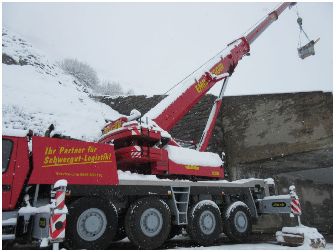
Abbildung 21: Aufstellung des Mobilkrans am passseitigen Galerieportal
