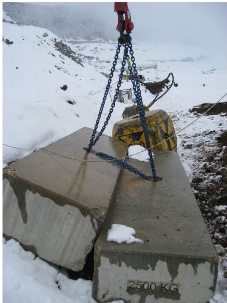
Abbildung 22: Gegengewichte zur Rückschlagsicherung des Krankopfes.
