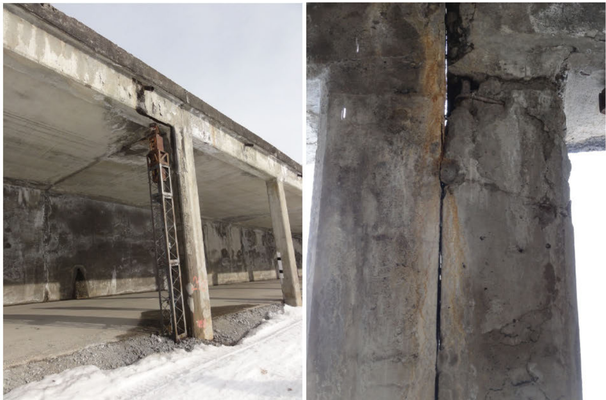
Abbildung 5: (links) Sanierungsbedürftige Stütze in Feld 4 mit schon vorhandener Hilfsstütze und (rechts) Detail Stützenkopf.
