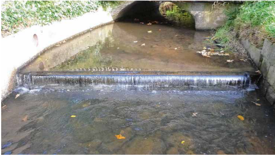
Abb. 3: Krebssperrre in einem Bereich mit Uferverbau. Zum Schutz vor seitlichem Überklettern sollen auf die Ufermauern im Sperrbereich noch Bleche aufgesetzt werden.
