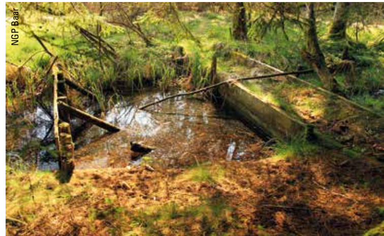
Abbildung 7: Im Rahmen des Naturschutzgroßprojektes Baar sollen die Wiedervernässungsmaßnahmen im Plattenmoos sowie im Schwenninger Moos optimiert werden, wie hier bei dieser älteren Sperre im Fördergebiet Plattenmoos.
