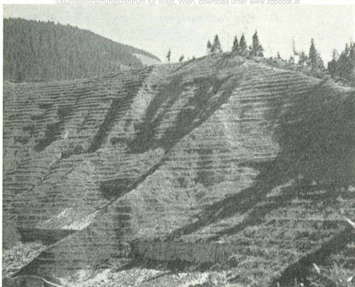
Abb. 124: Teil des fertig begrüntes Filpittertobels im Gallinabach bei Feldkirch. Grünverbauung 1–3 Jahre alt.
