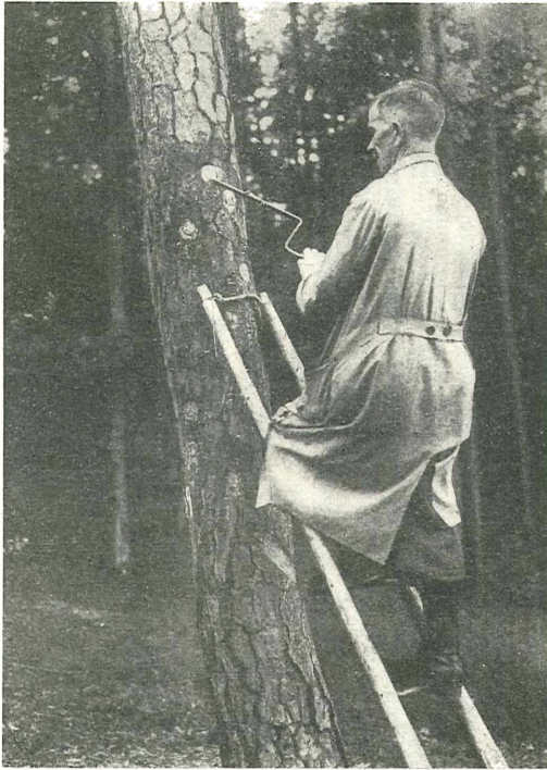
Abb. 4. Herstellung der Bohrungen.
