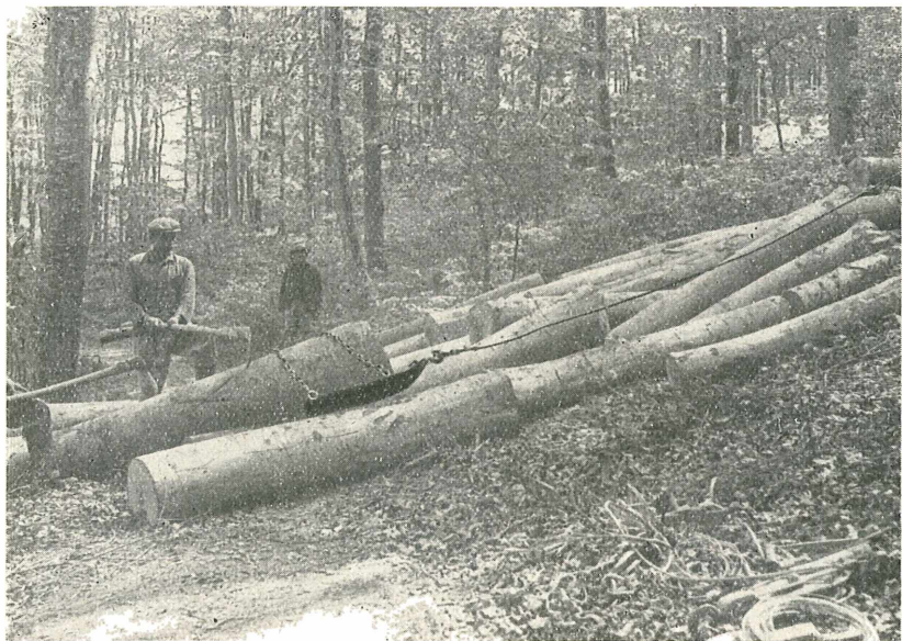
Abb. 4: Aufseilen eines Buchenbloches mit 60 cm Geschwindigkeit (ohne eingeschaltete lose Rolle) zu einem Lager am Abfuhrweg.
