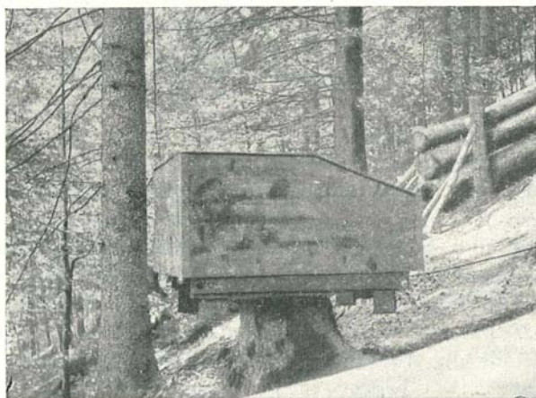
Abb. 17: Mariabrunner Abseil- und Rückmaschine, auf einem Stocke verankert in Ruhestellung unter einer Überkiste.
