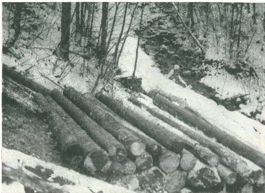
Abb. 26: Abgeseiltes, auf der Verladerrampe beim Abfuhrweg aufgegantertes Holz.
