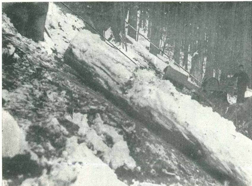
Abb. 50: Abseilen von Holz. Blick auf die Einkehr im Vordergrund und auf die Maschine in Arbeitsstellung rechts im Mittelgrunde des Bildes.
