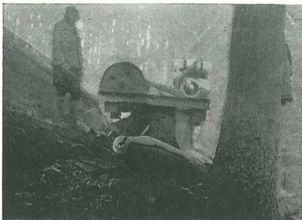
Abb. 55: Behälter für die Unterbringung der Befestigungsmittel (im Vordergrund des Bildes liegend). Nur auf regelmäßig gebauten Gleitbahnen verwendbar.
