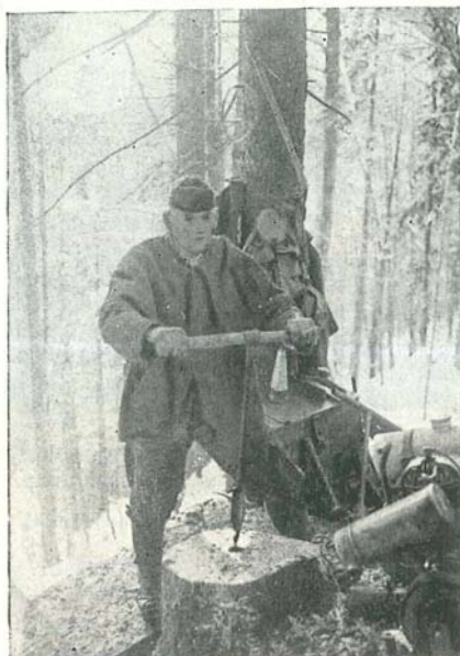
Abb. 10: Vorbereitungen zum Verankern der Maschine auf einem Stocke. Bohren eines Loches für die Grundschraube.
