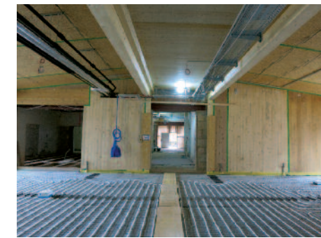
↑ Wärme für den Untergrund: Verlegung der Fußbodenheizung im März 2018
