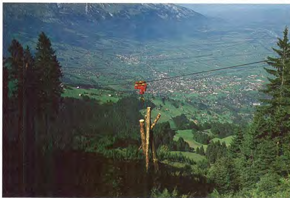
Seilkraneinsatz am Grabserberg SG
