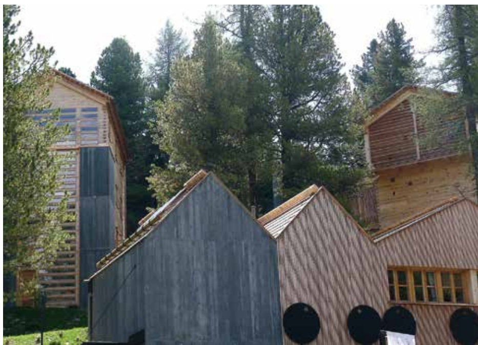
Türme im Wald in Holzblockbauweise.
