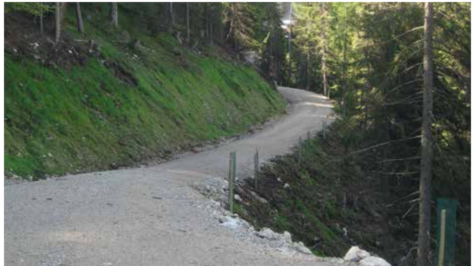
Abbildung 1: Anpassung der Forststraße an erhöhte Verkehrsintensitäten.
