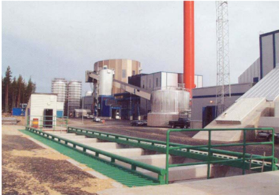
Abbildung 10: Von BMH-Wood Technology entwickelte Holzübernahmestation bei einem finnischen Biomasse-Kraftwerk
