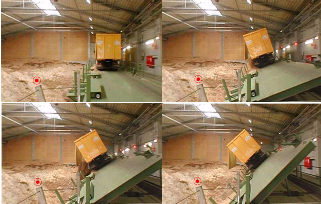
Abbildung 27: Beim Biomasse-Heizkraftwerk Pfaffenhofen (27 MW Biomassekessel) in Deutschland wurde nach Angaben der Betreiber in der Anlagenkonzeption der Brennstofflogistik besondere Bedeutung beigemessen. Der jährliche Brennstoffbedarf von 80.000 t bzw. 250.000 srm wird zum Großteil durch Waldhackgut der umliegenden Waldbesitzer und zum kleineren Teil durch unbehandeltes Industrierestholz abgedeckt. Das Brennstofflager beim Heizkraftwerk reicht für etwa 5 Tage, im Nahbereich der Anlage sind Zwischenlager eingerichtet, die mit ungehacktem Holz beliefert werden können. Für Zwischenlagerung und Transport des fertigen Hackgutes wird ein einheitliches Kontainersystem mit einem Fassungsvermögen von 40 bis 80 m 3 eingesetzt 20 .
