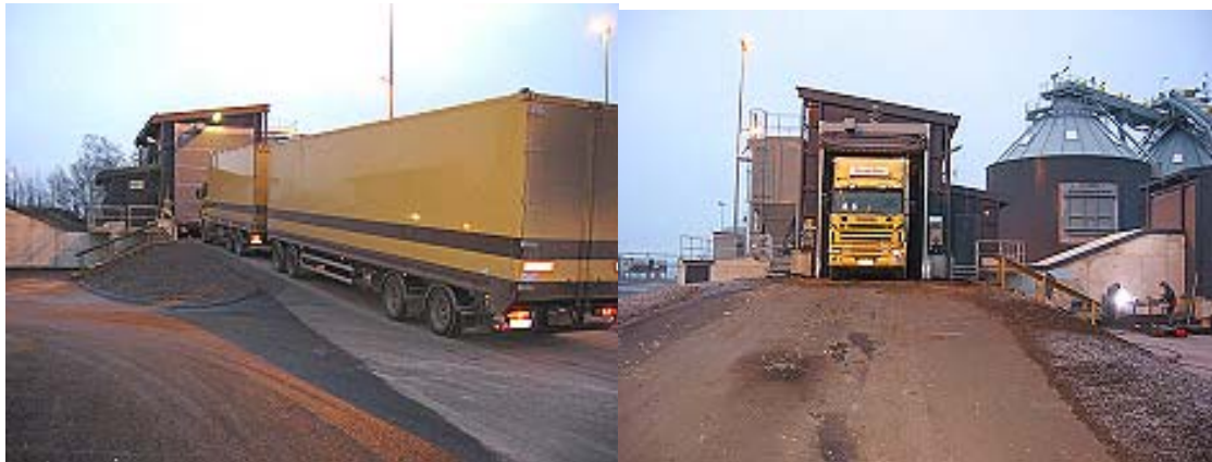
Abbildung 20: Moderne Übernahmestation des Kraftwerkes Kotka. In der Übernahmestation ist eine Absaugvorrichtung eingebaut, um Staubbelastungen der Umgebung während der LKW-Entladung zu vermeiden.
