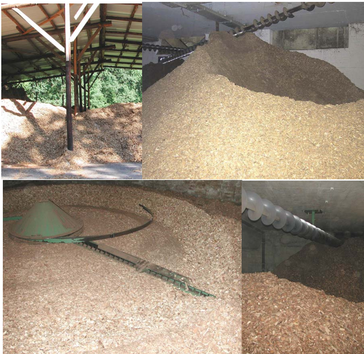
Abbildung 39: Bei kleinen Biomasseheizanlagen bis 500 kW Heizlast wird der Brennstoffqualität große Bedeutung beigemessen. Unregelmäßige Stückigkeit und zu hoher Wassergehalt können große Probleme beim Anlagenbetrieb verursachen.
