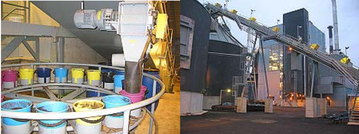
Abbildung 21: Die Probennahme in der Übernahmestation des Kraftwerkes Kotka erfolgt für jede LKW-Lieferung vollautomatisch mit einer hydraulisch gesteuerten Entnahmevorrichtung im Bereich des Förderbandes der Entladestation.
