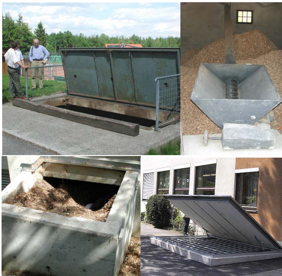
Abbildung 30: Bei Kleinanlagen bis 500 kW Heizlast werden hohe Anforderungen an die Qualität des Brennstoffes gestellt. Häufig sind einfach und rasch zu bedienende Übernahmestationen für die Wirtschaftlichkeit der Energieholzzustellung von erheblicher Bedeutung.
