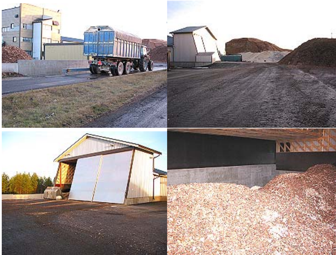
Abbildung 23: Brennstoffsilo und Brennstofflagerplatz des Biomasseheizwerkes Suomussalmi.
