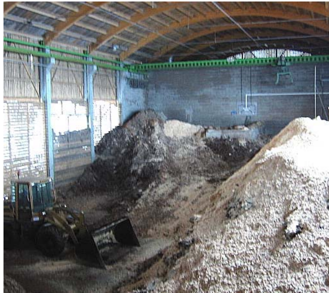
Abbildung 40: Brennstofflager eines großen Biomasseheizwerkes in Österreich mit einem Brennstoffmix aus unterschiedlichsten Energieholzsortimenten. Bei großen Kesselanlagen werden von den Kesselherstellern Brennstoffe mit einem Wassergehalt zwischen 10 % bis 60 (65) % zugelassen. Die Heizwerksbetreiber mischen die unterschiedlichen Brennstoffe in der Regel nach den eigenen Erfahrungswerten für den störungsfreien Anlagenbetrieb ab.
