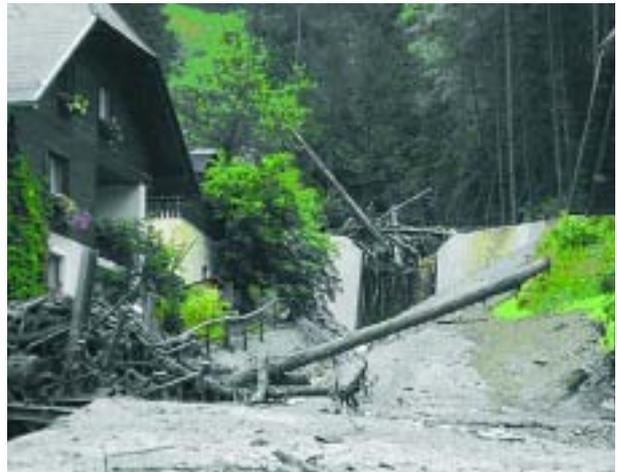
Abbildung 3.1.2.1-1: Verkleuste Geschiebedosiersperre im Rauschergraben (Foto: WLV, Gebietsbauleitung Ost- und Weststeiermark).
