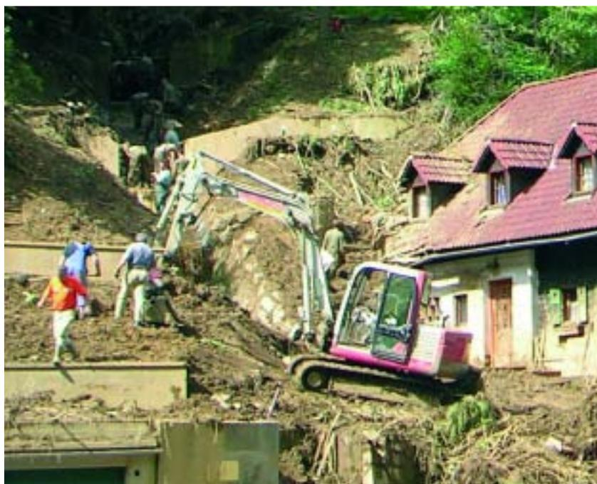
Abbildung 4.1.2.1-2: Schadensreduzierende Wirkungsweise einer Künette (Haslau, linksufriger Seitengraben Teitzbach).
