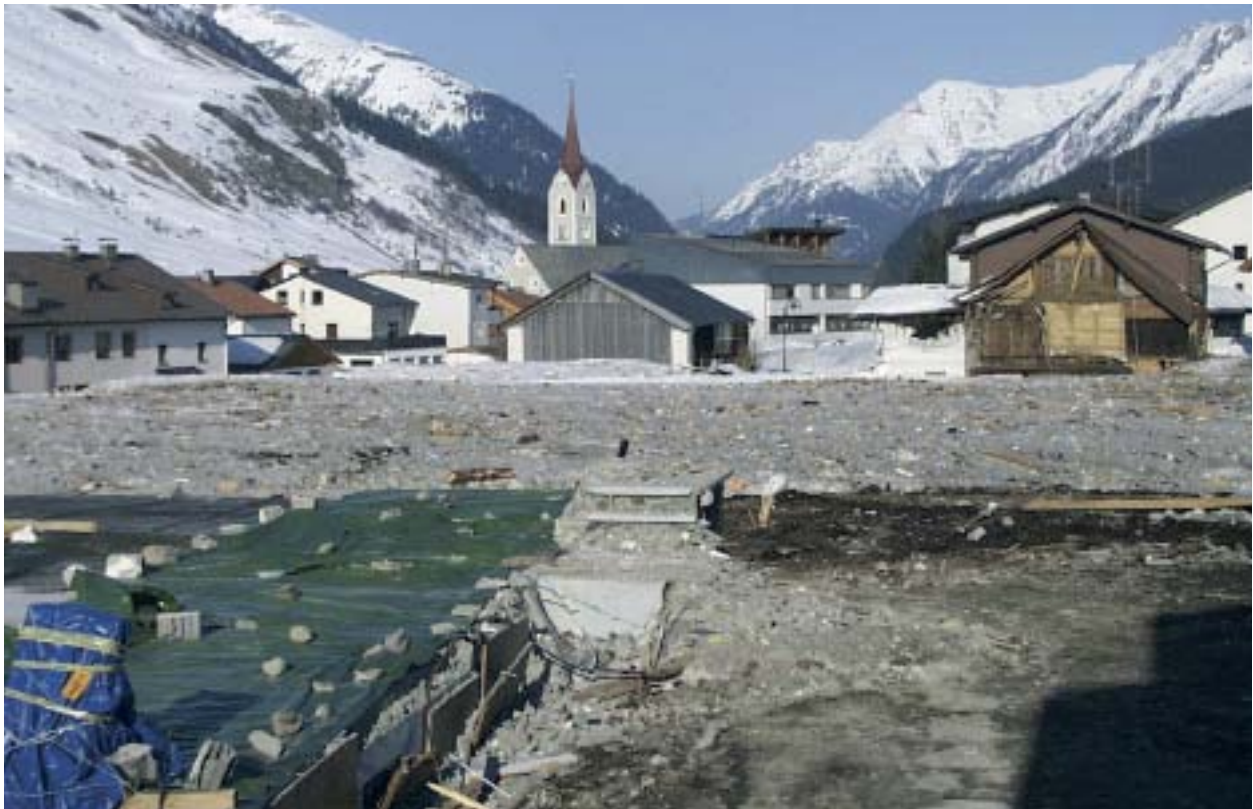
Lawinenschäden im Ortszentrum von Galtür (Tirol), Lawine vom 23.2.1999. Foto: Lawinenwarndienst Tirol
