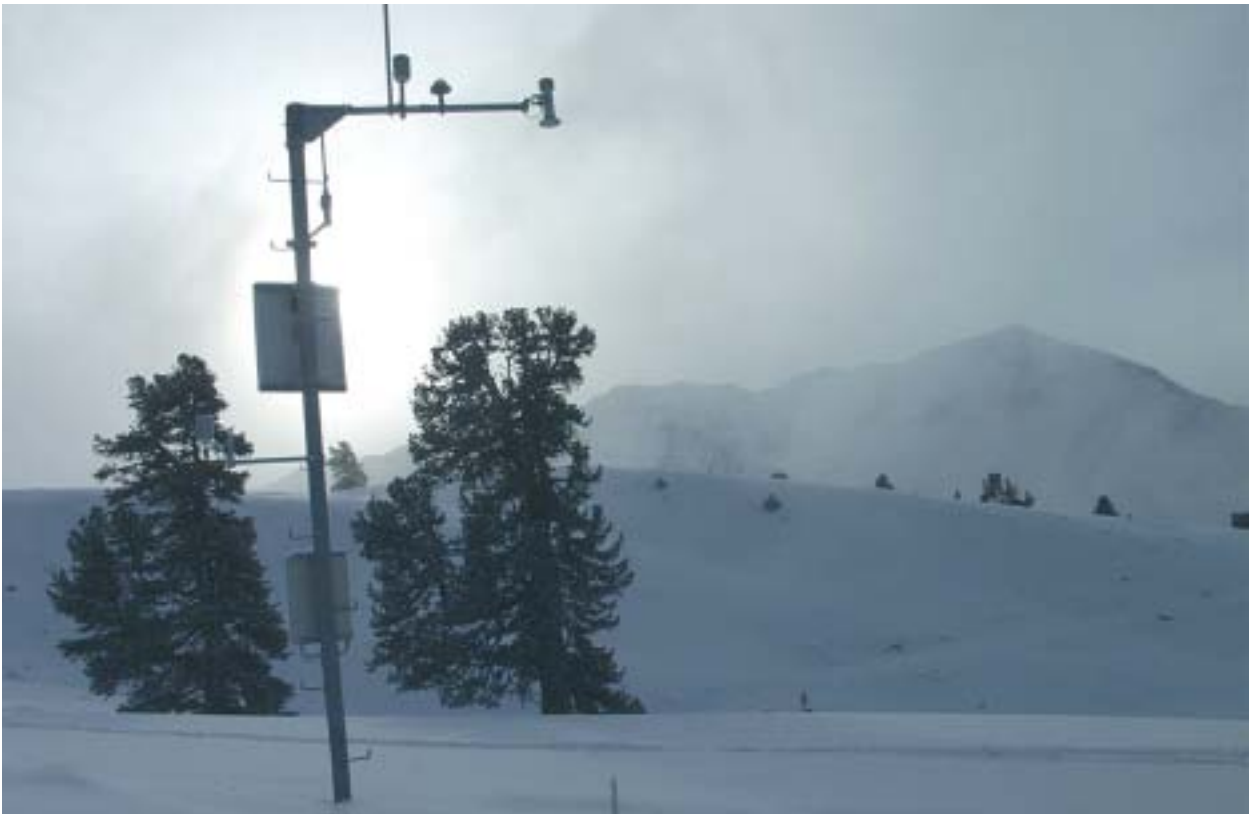
Wetterstation des Lawinenwarndienstes Tirol - Kleiner Beil in Alpbach (Tirol) (Foto vom 29.12.2003). Foto: Lawinenwarndienst Tirol
