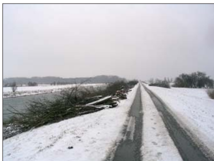
Bearbeiteter Deichabschnitt, Ast- und Strauchwerk kann zur Weiterverwertung verbracht werden
