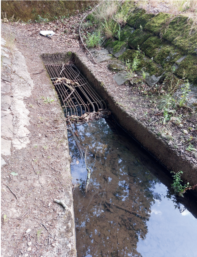
Abbildung 4 Rechen vor und nach der Erneuerung. (Foto: Ammar Fallaha)
