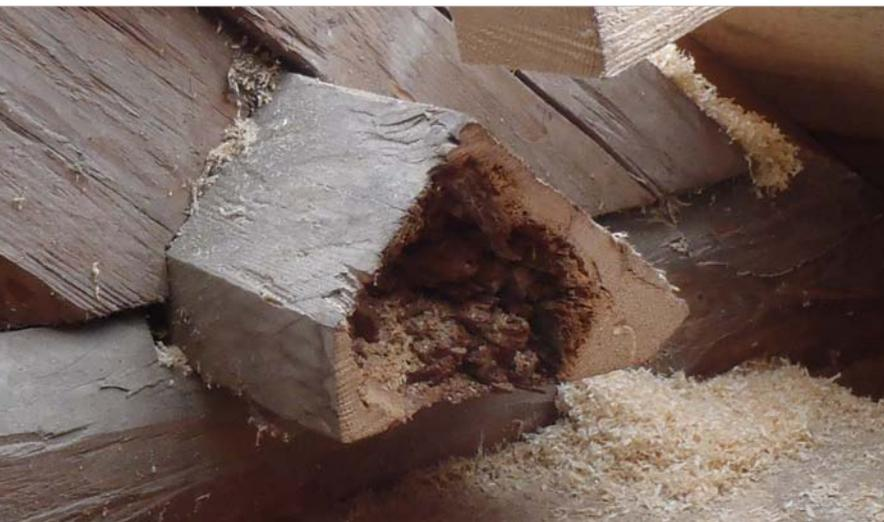
Die Schäden die ein holzerstörender Pilz an einer Holzkonstruktion verursacht, wie hier in einem Dachstuhl, sind oft von außen nicht erkennbar.
