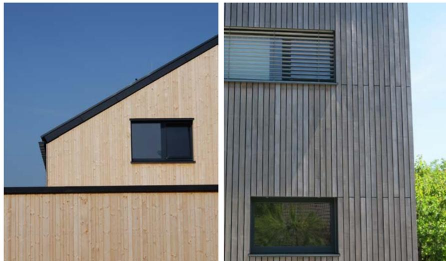
Reduzierte Vordächer und offene Bauweisen führen zu geänderten Anforderungen an moderne Holzfassaden.
