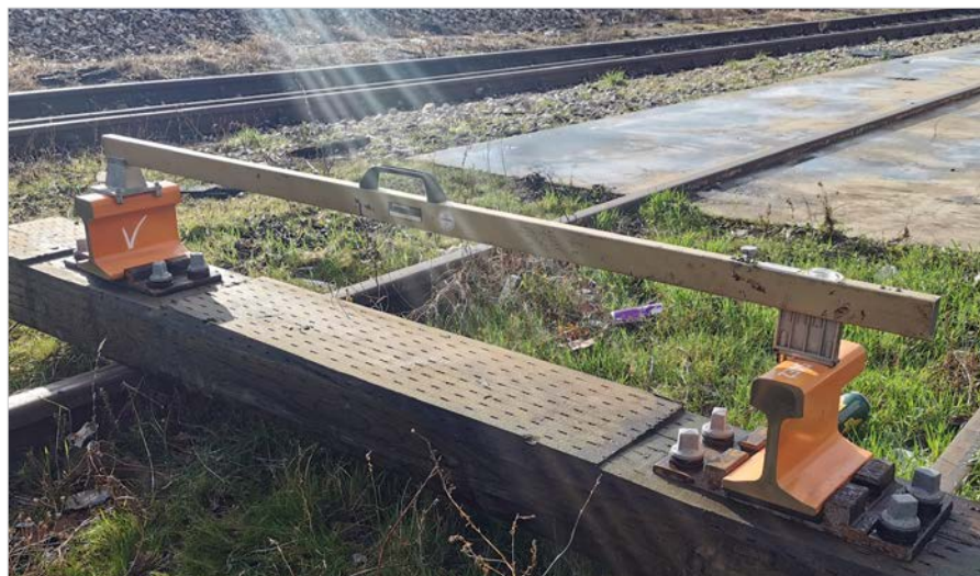
Eine der Aufgaben bei der Qualitätssicherung durch die Holzforschung Austria ist die Vermessung der Spurweite
