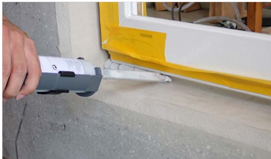
Montage einer Außentür durch eine elastische Verklebung in einer Betonwand
