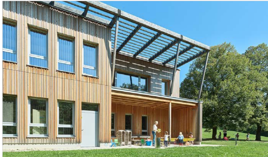
Die drei Pavillons des städtischen Kindergartens in Pötzleinsdorf wurden mit dem Holzbaupreis wienwood 21 prämiert
