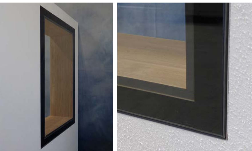
Außen flächenbündig mit Schattennut
