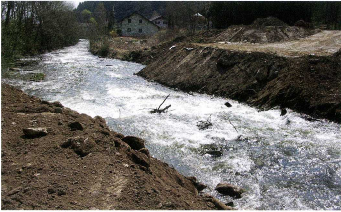
Anschüttungen im Bach für den Bau einer Brücke zur Umfahrung von Bad St. Leonhard.
