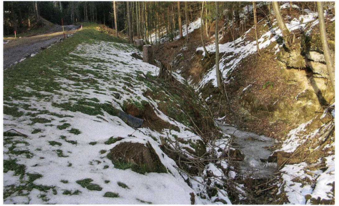
Eine Straßenentwässerung direkt in den Bach ohne Absetzbecken.
