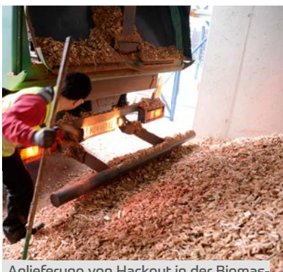
Anlieferung von Hackgut in der Biomasseheizanlage Rosen Waibel
