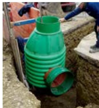
den. Die Anschlüsse der Schächte können auch dem Gefälle entsprechend eingeschweißt werden. Um einen einfacheren Einstieg zu ermöglichen, besteht zudem die Option, Steigbügel im Schacht anzubringen. Diverse Schieber, Prallwände oder Gerinne können ebenfalls integriert werden.
