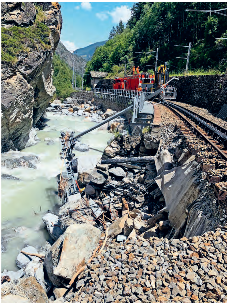
Hochwasserschäden an der Bahnstrecke Visp-Zermatt im Sommer 2024.
