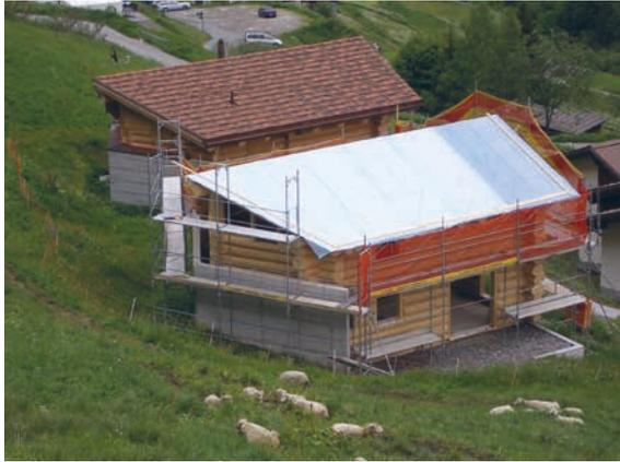
Abb. 11: Blockhaus wird durch eine Betonmauer geschützt. Beim Schneegleiten hat die Höhe der Mauer der extremen Schneehöhe zu entsprechen (typischerweise für 100 Jahre).
