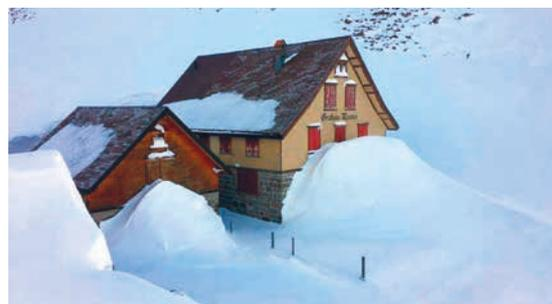
Abb. 9: Infolge Windeinwirkung hat sich vor den Gebäuden eine meterhohe Schneebank gebildet. Auf die Fassade wirkt der Ruhedruck, der z. B. Fenster oder Türen eindrücken kann.
