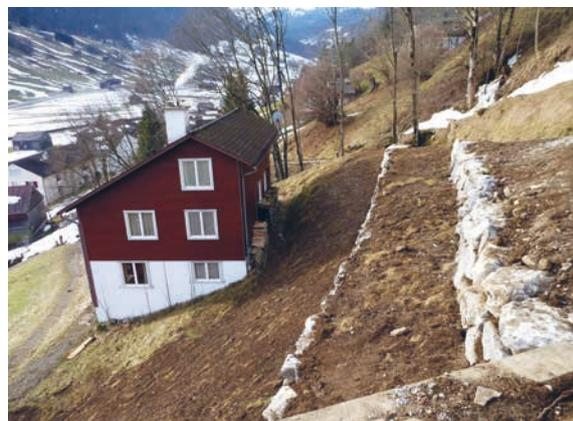
Abb. 16: Durch eine Terrassierung kann die Schneedecke am Gleiten gehindert werden. Eine Terrassierung kann ein Schneegleitproblem permanent lösen.
