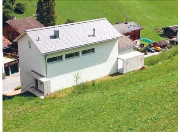
Abb. 12: Wohnhaus am Fuss eines Gleitschneehanges. Zugang und Terrasse sind mit Betonmauern geschützt. Das Erdgeschoss weist bergseitig keine Fenster auf.
