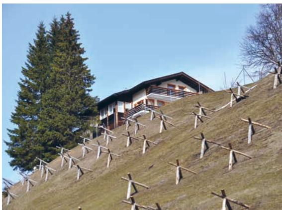
Abb. 15: Dreibeinböcke verhindern das Gleiten und Kriechen der Schneedecke. Sie werden flächenhaft eingesetzt (Raster etwa 2,0–2,5 m). Kosten etwa CHF 250.– pro Bock.
