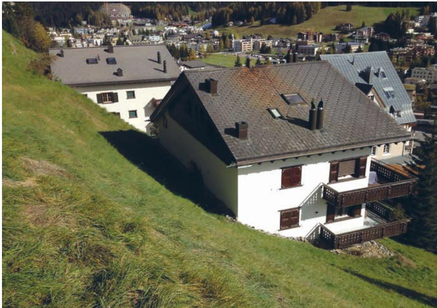
Abb. 4: Kurzer (Hanglänge  $L < \text{etwa } 20 \text{ m}$ ) und rund  $40^\circ$  geneigter Steilhang im Siedlungsgebiet. Die Bewertung ergibt 13 Punkte. Das Ausscheiden von Schneegleiten ist angezeigt. Auf das Gebäude wirken Schneedruckkräfte. Lawinen können vernachlässigt werden.
