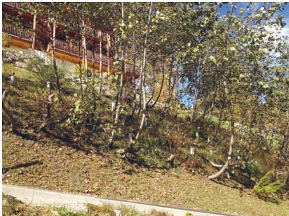
Abb. 13: Ein kurzer Steilhang im Siedlungsgebiet wurde mit Pfählen gesichert und aufgeforstet. Bei starkem Schneegleiten ist eine Verpfählung oft nicht ausreichend (z. B. Kombination mit Dreibeinböcken oder Berme).
