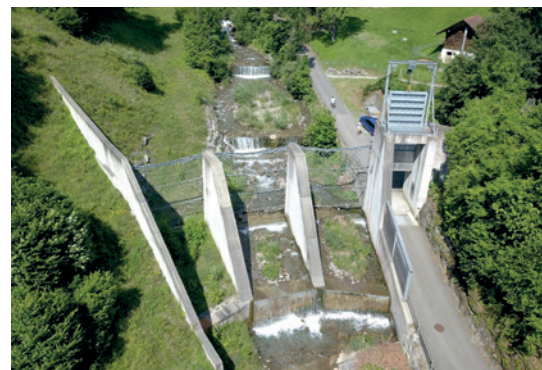
Sperre unterwasserseitig (Bild: [F]).
