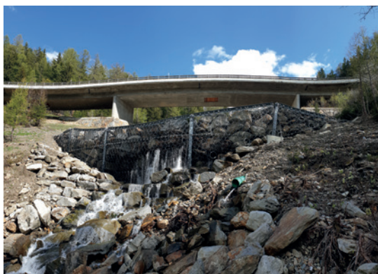
Sperre UX-180-H6 vorverfüllt in Blickrichtung Bach aufwärts (Bild: [G]).
