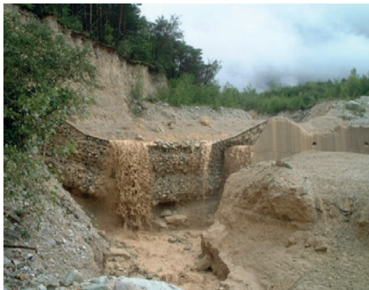
Sanierungsabschnitt 1 mit VX-Barriere gefüllt (Bild: [G]).
