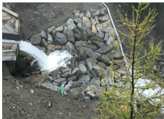
Sperre mit grossen Blöcken vorverfüllt, Blick von oben (Bild: [I]).
