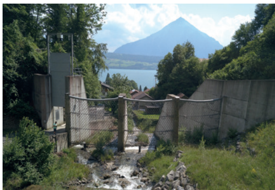
Sperre oberwasserseitig (Bild: [F]).
