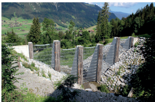
Sperre oberwasserseitig (Bild: [F]).
