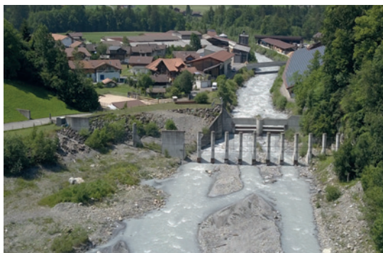
Sperre oberwasserseitig (Bild: [F]).
