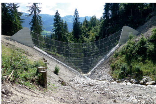
Sperre oberwasserseitig (Bild: [F]).
