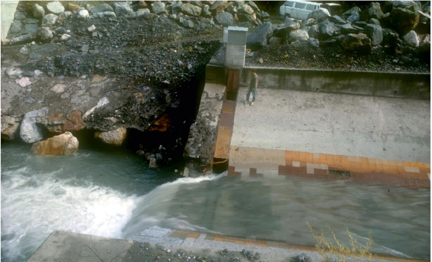
Abb.4.4: Dokumentation der Beschädigungen an der Abflussmessstelle Oselitzenbach nach dem Ereignis vom 14. Oktober 1993.
