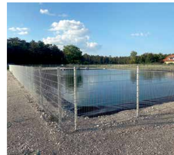
Die Errichtung eines Löschteiches mit einer Teichfolie.
