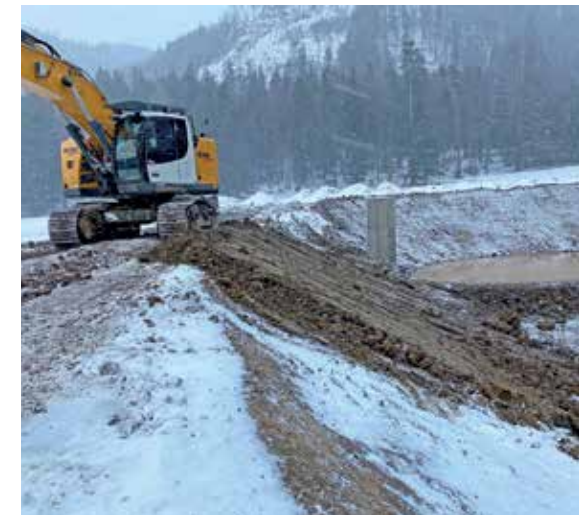
Die Errichtung eines Löschteiches mittels Lehm Schlag.
