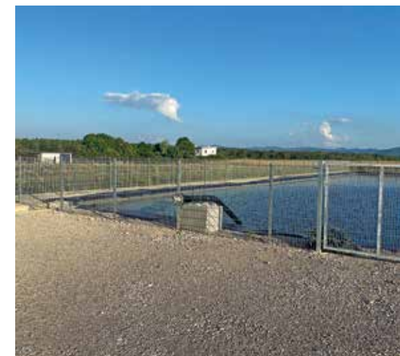
Löschwasserentnahme durch eine Steigleitung.
